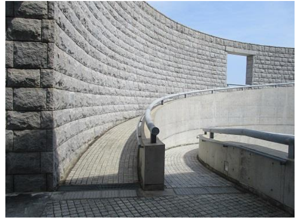
コンクリート壁と通路（スロープ）
