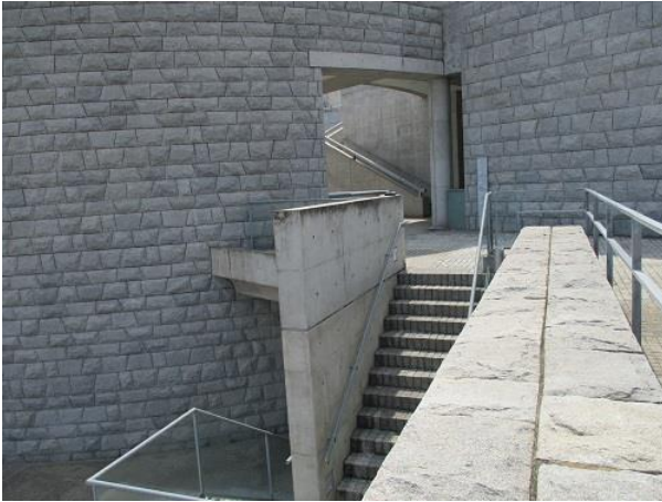
階段とコンクリート壁
